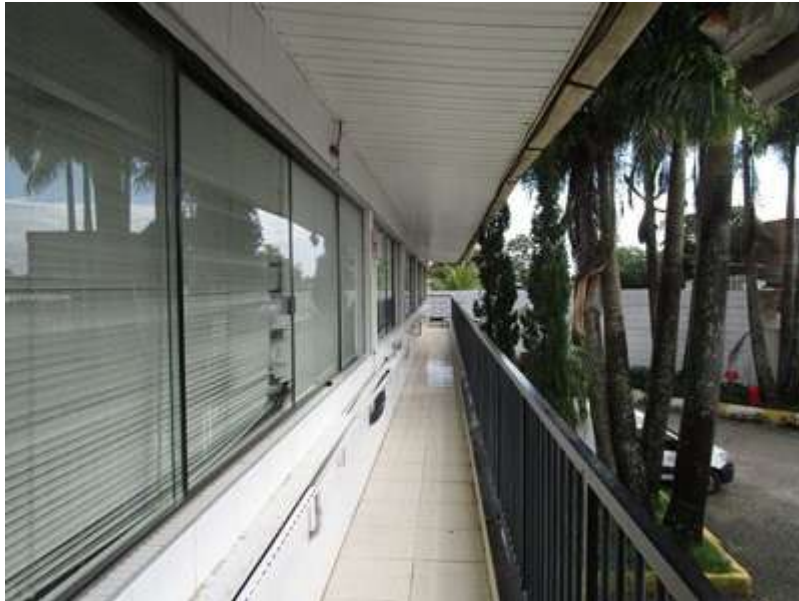
VISTAS DO AVALIANDO- ÁREA INTERNA
