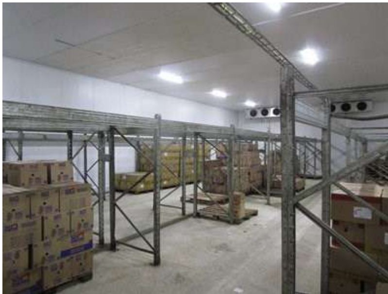
VISTAS DO AVALIANDO- ÁREA INTERNA
