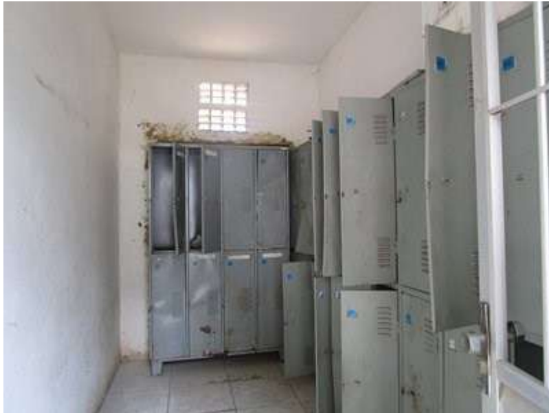
VISTAS DO AVALIANDO- ÁREA INTERNA
