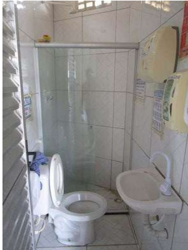
VISTAS DO AVALIANDO- ÁREA INTERNA
