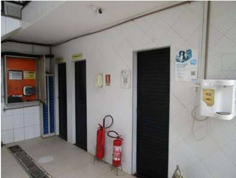
VISTAS DO AVALIANDO- ÁREA INTERNA
