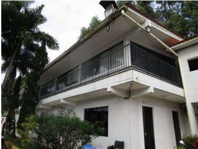
VISTAS DO AVALIANDO- PRÉDIO ADMINISTRATIVO
