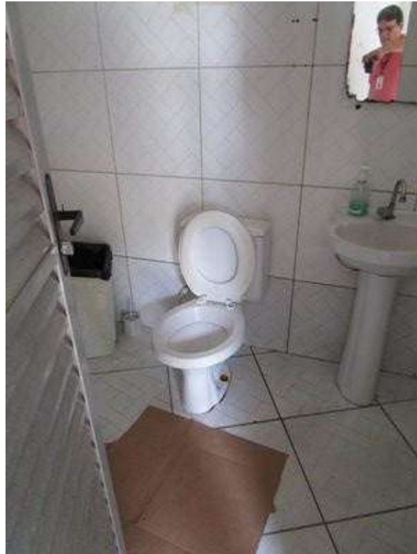
VISTAS DO AVALIANDO- ÁREA INTERNA
