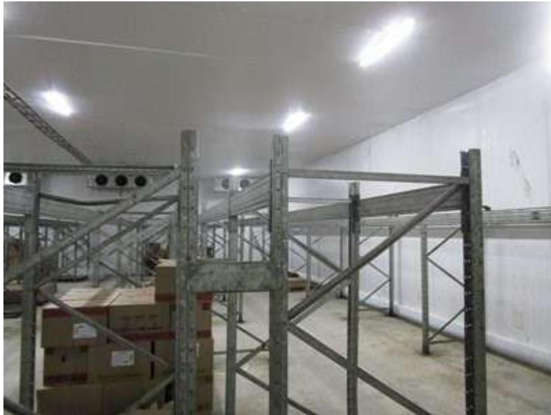
VISTAS DO AVALIANDO- ÁREA INTERNA
