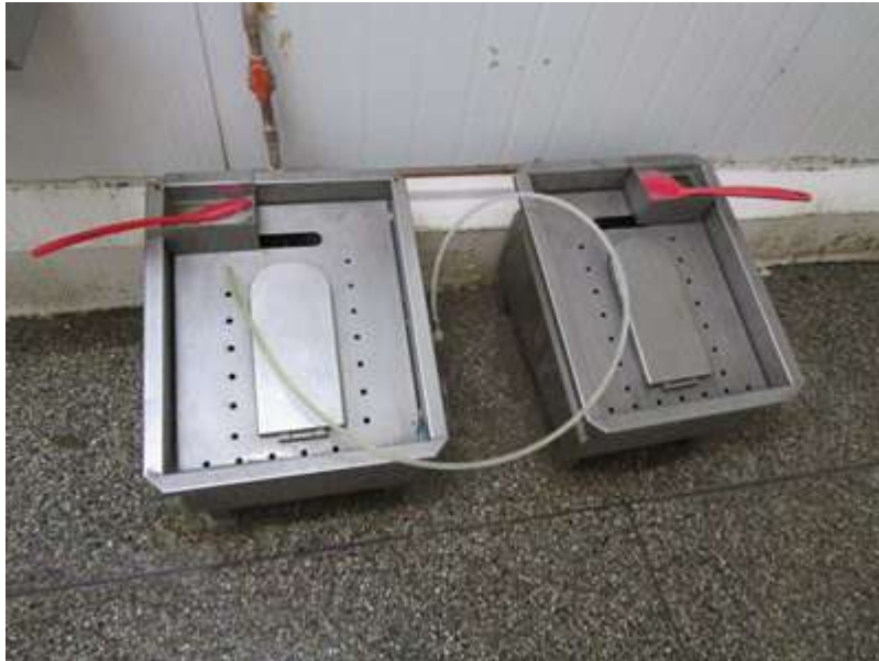
VISTA DAS BACIAS DE LAVAGEM DE BOTAS
