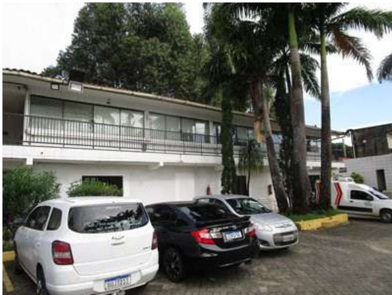
VISTAS DO AVALIANDO- PRÉDIO ADMINISTRATIVO
