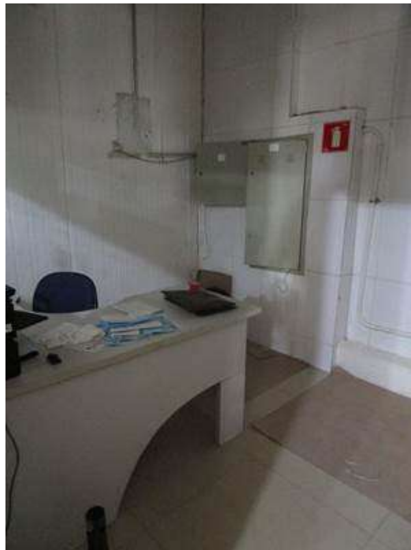
VISTAS DO AVALIANDO- ÁREA INTERNA
