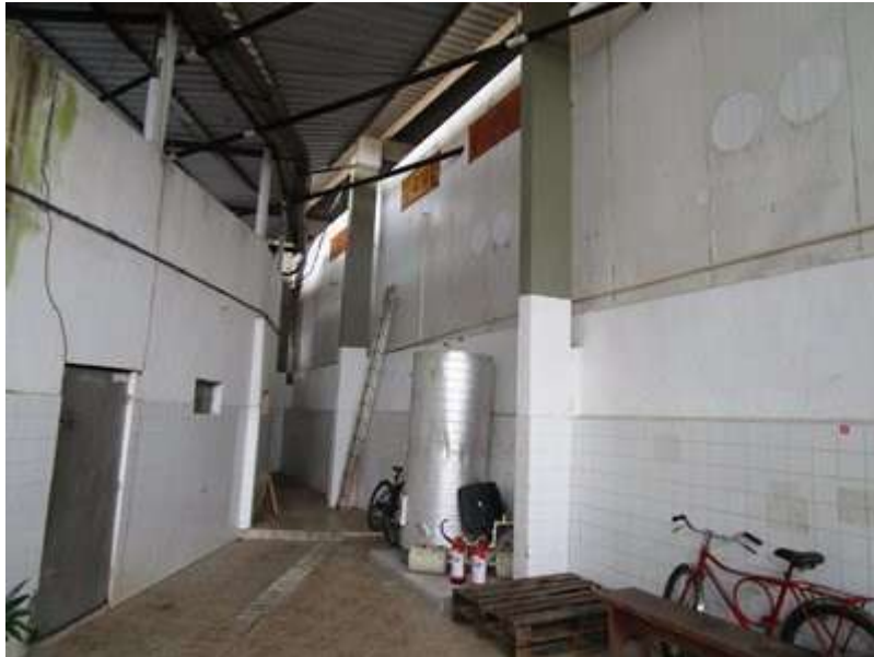
VISTAS DO AVALIANDO- ÁREA INTERNA/ ACESSO AO REFERITÓRIO/ VESTIÁRIOS
